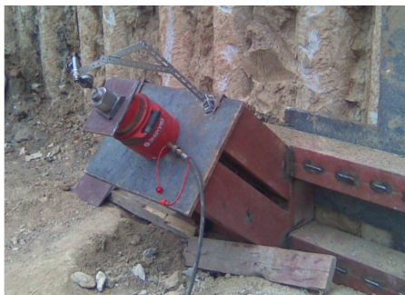
Рис. 3. Общий вид стенда в момент испытания свай-анкеров первого яруса.
