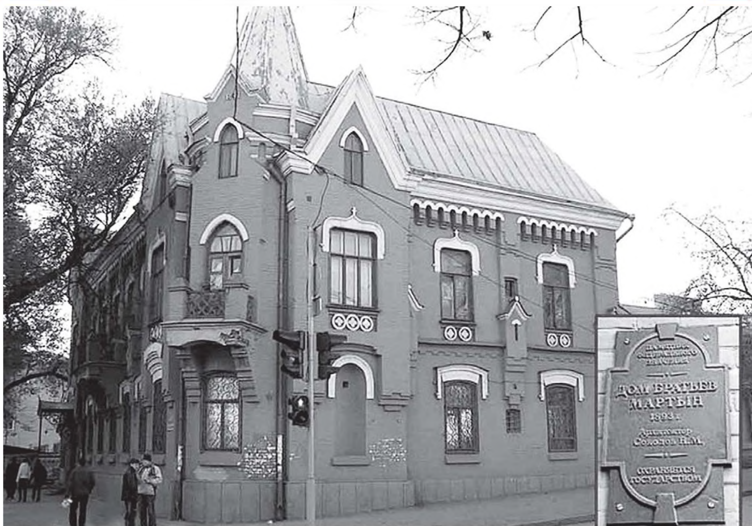
Технология применения буроинъекционных свай спасла памятник от разрушения.
